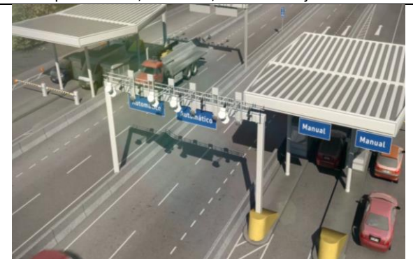
Maqueta Virtual, Ruta F-20, Pórtico telepeaje Free Flow y Caseta de Cobro Manual, Dm 6.500
