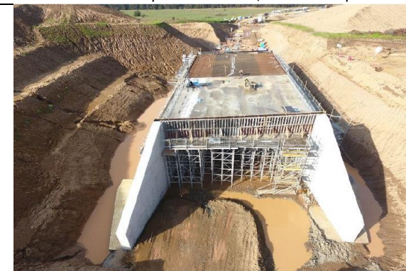
Formación Terraplenes Sector 2, Enlace Campiche
