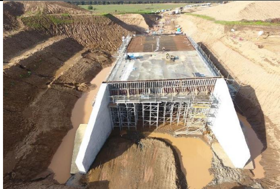
Formación Terraplenes Sector 2, Enlace Campiche
