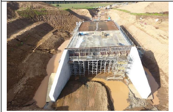
Ejecución PS Campiche, Sector 2.
