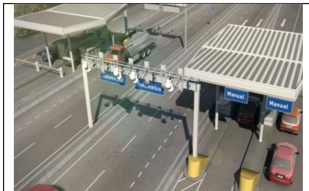
Maqueta Virtual, Ruta F-20, Pórtico telepeaje Free Flow y Caseta de Cobro Manual, Dm 6.500
