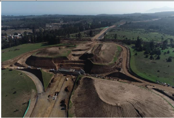
Formación Terraplenes Sector 2, Enlace Campiche
