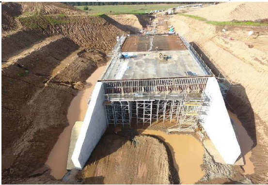
Ejecución PS Campiche, Sector 2.
