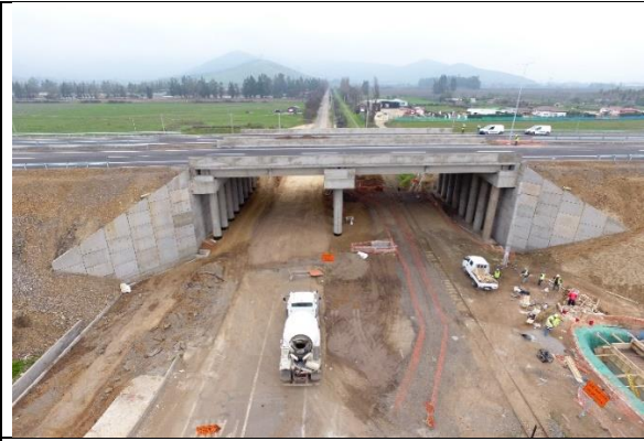
Ejecución PS Las Romazas, Ruta F-20.
