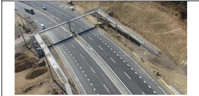
Pasarela N° 3 - Vista General.
