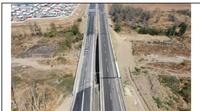
Puente Nogales – Vista general.
