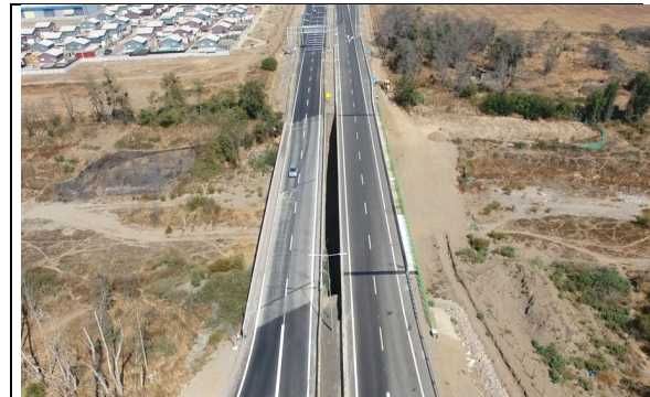
Puente Nogales – Vista general.
