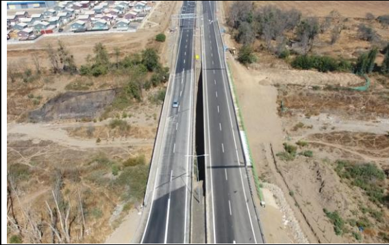
Puente Nogales – Vista general.
