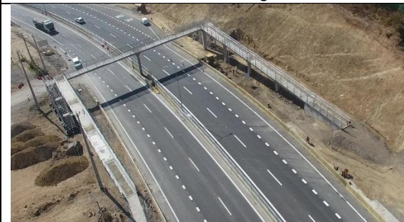
Pasarela N° 3 - Vista General.
