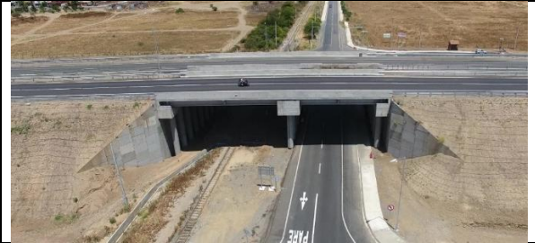
Ejecución PS Las Romazas, Ruta F-20.
