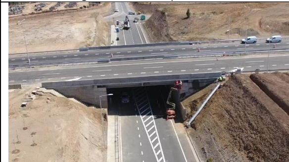
P.S. Enlace F-190 - Vista General.
