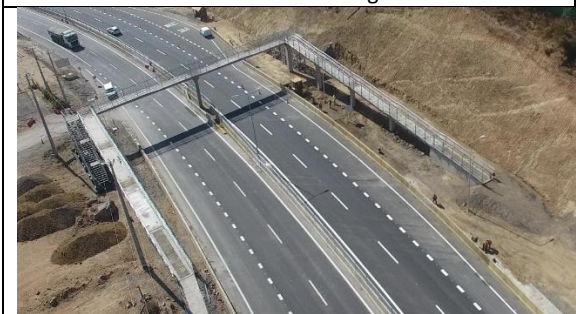
Pasarela N° 3 - Vista General.
