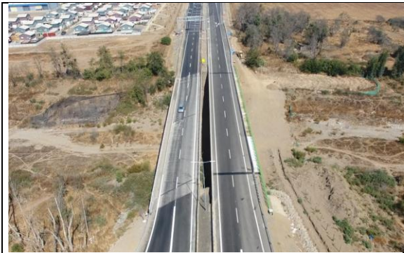
Puente Nogales – Vista general.
