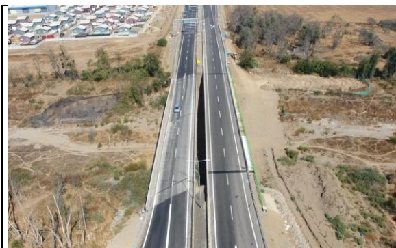
Puente Nogales – Vista general.
