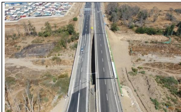
Puente Nogales – Vista general.
