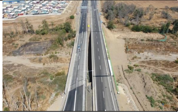
Puente Nogales – Vista general.
