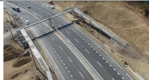
Pasarela N° 3 - Vista General.
