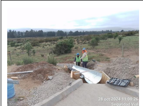
Sector 2 - Km 29+520. Trabajos en instalación de canaleta corrugado.
