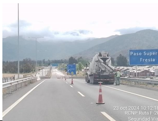
Sector 1 - Km 1.4 Trabajos de hormigonado de fundaciones de señaléticas. Margen izquierdo
