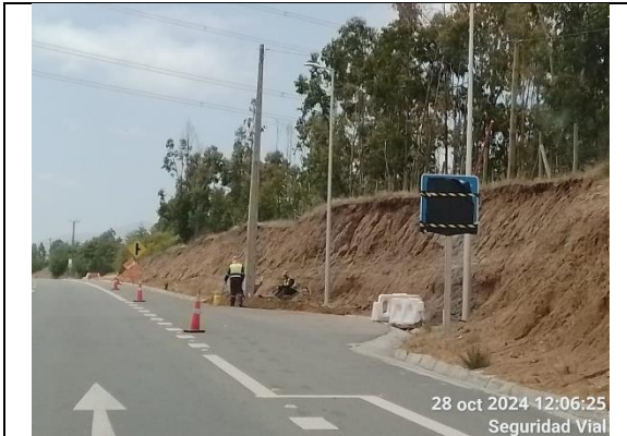
Sector 1 – Km 22.3 Margen izquierdo. Trabajos postación eléctrica -Subcontrato Conecta.
