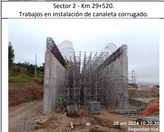
Sector 2 – Km 32+240. Trabajos de instalación de andamios.
