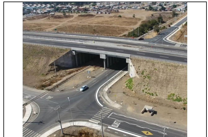
PS FFCC Las Romazas – Vista general.
