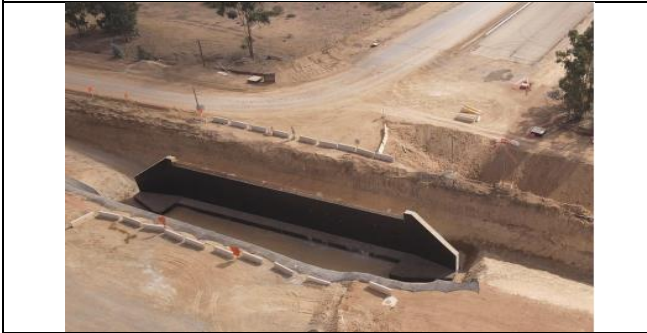
Paso Superior Ruta F-170. Vista general.
