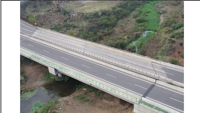
Puente Nogales – Vista general.
