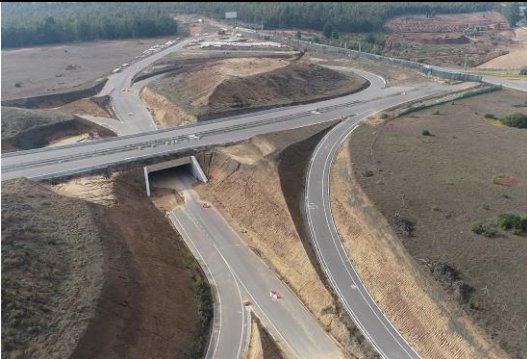
Paso superior enlace Campiche - Vista General.
