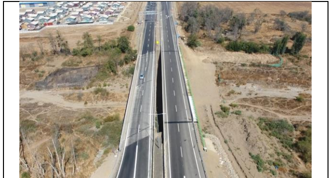
Puente Nogales – Vista general.
