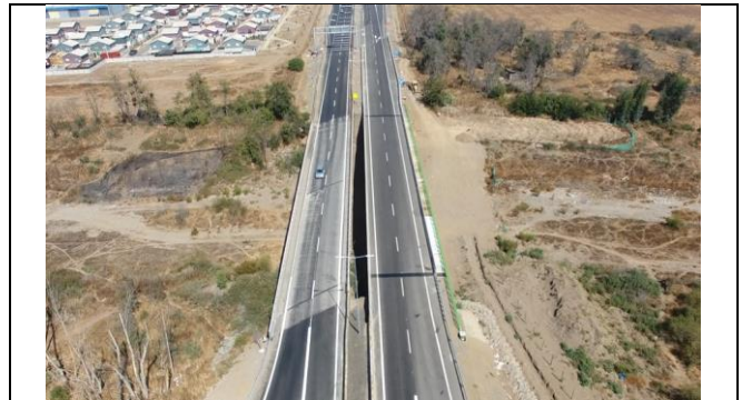
Puente Nogales – Vista general.
