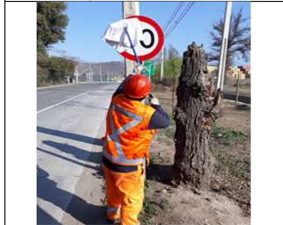
Mantenimiento y conservación de señales verticales
