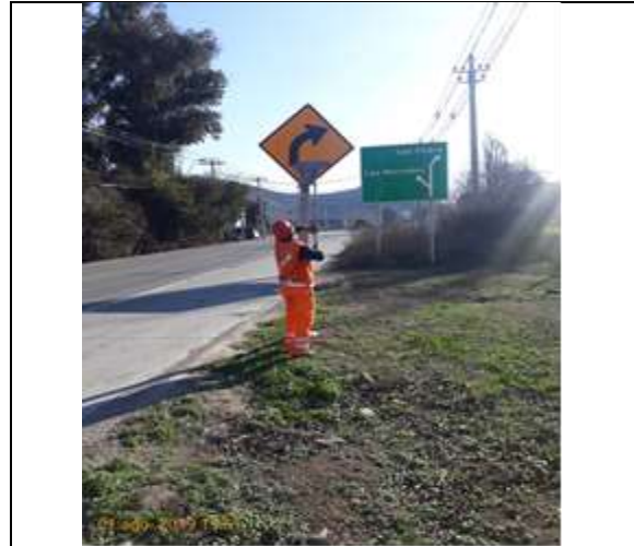
Mantenimiento y conservación de señales verticales
