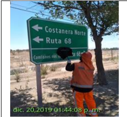
Mantenimiento y conservación de señales verticales
