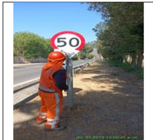
Mantenimiento y conservación de señales verticales
