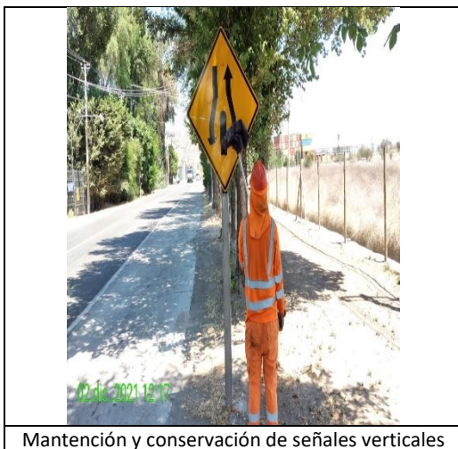
Mantenimiento y conservación de señales verticales
