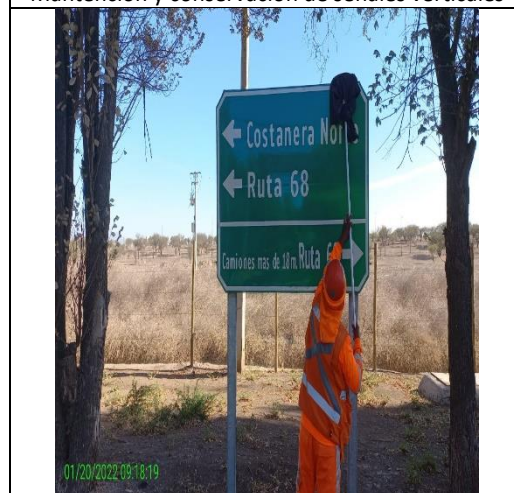
Mantenimiento y conservación de señales verticales
