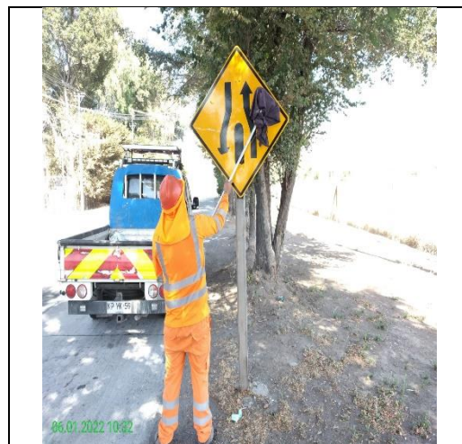
Mantenimiento y conservación de señales verticales
