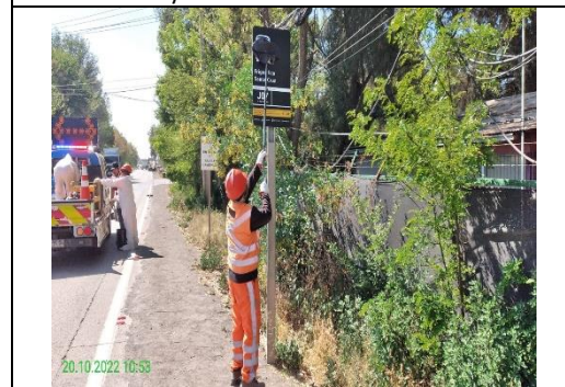
Mantenimiento y conservación de señales verticales
