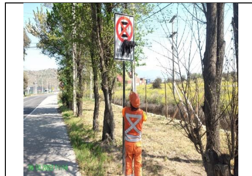
Mantenimiento y conservación de señales verticales
