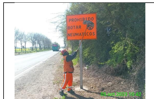
Mantenimiento y conservación de señales verticales
