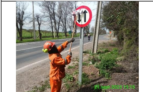
Mantenimiento y conservación de señales verticales
