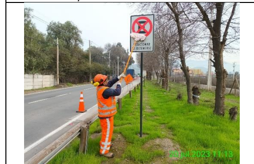
Mantenimiento y conservación de señales verticales
