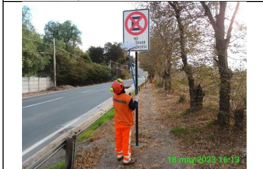
Mantenimiento y conservación de señales verticales
