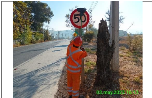
Mantenimiento y conservación de señales verticales
