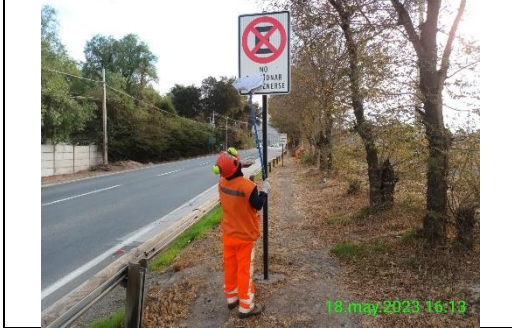
Mantenimiento y conservación de señales verticales
