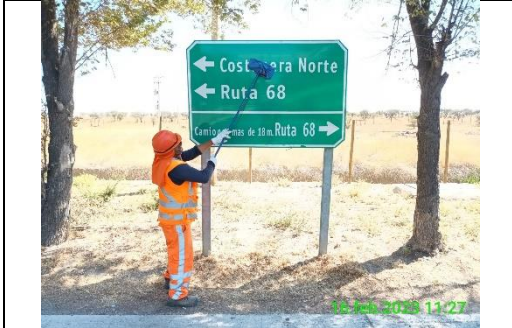
Mantenimiento y conservación de señales verticales
