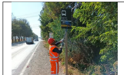
Mantenimiento y conservación de señales verticales
