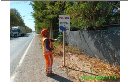
Mantenimiento y conservación de señales verticales
