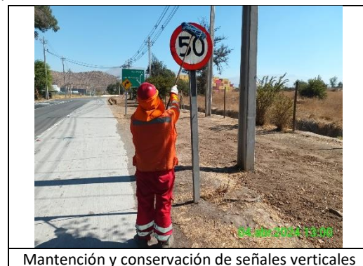
Mantenimiento y conservación de señales verticales
