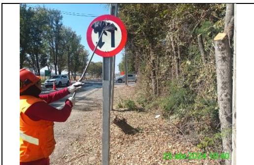
Mantenimiento y conservación de señales verticales
