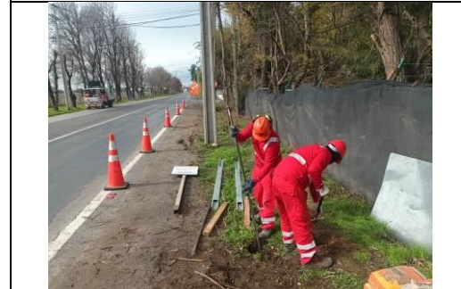
Mantenimiento y conservación de señales verticales
