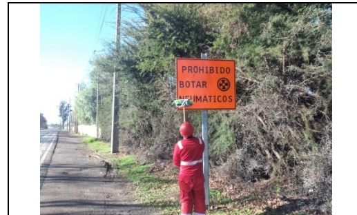
Mantenimiento y conservación de señales verticales
