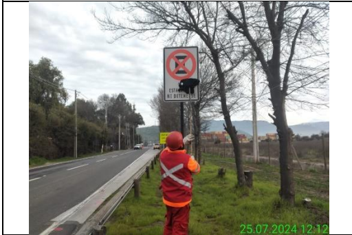
Mantenimiento y conservación de señales verticales
