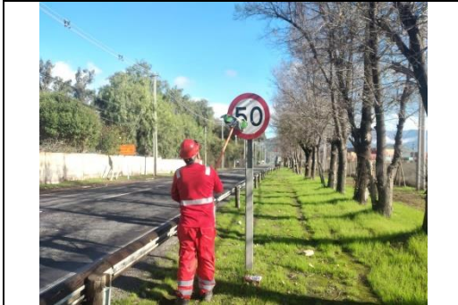
Mantenimiento y conservación de señales verticales
