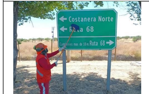
Mantenimiento y conservación de señales verticales
