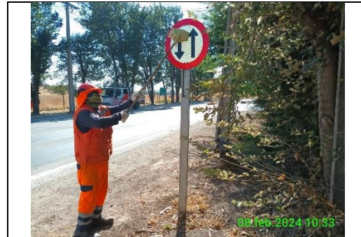
Mantenimiento y conservación de señales verticales
