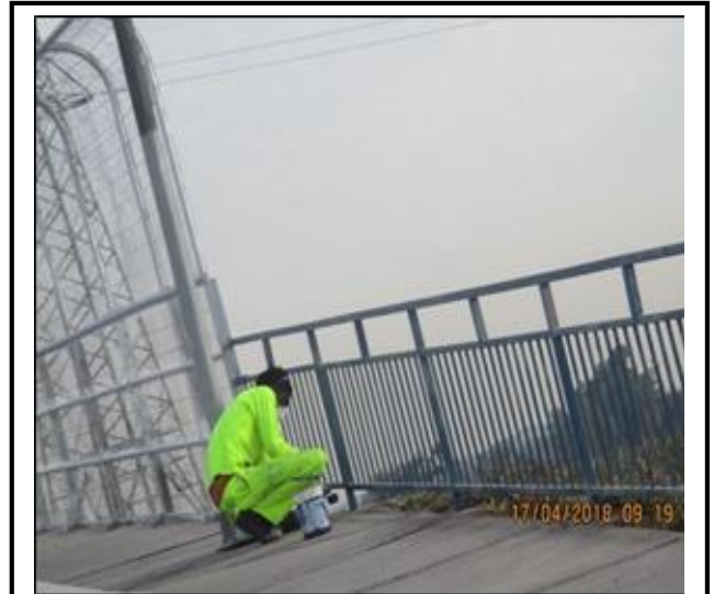
Mantenición de vallas peatonales.
