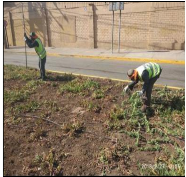
Reparación de paisajismo
