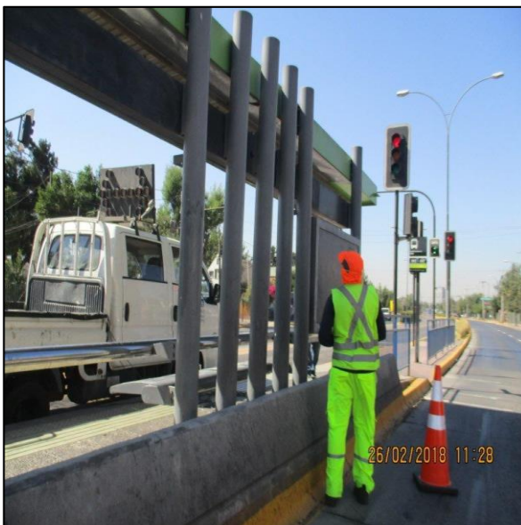
Mantenimiento de refugios peatonales
