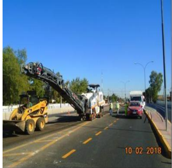
Repavimentación sector Emeres
