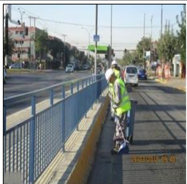
Limpieza de calzada.
