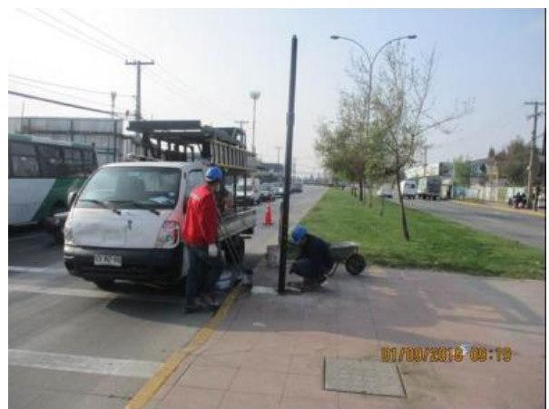
Mantenimiento de Semáforos
