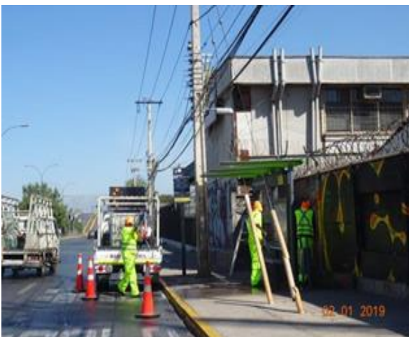
Mantenimiento de refugios peatonales
