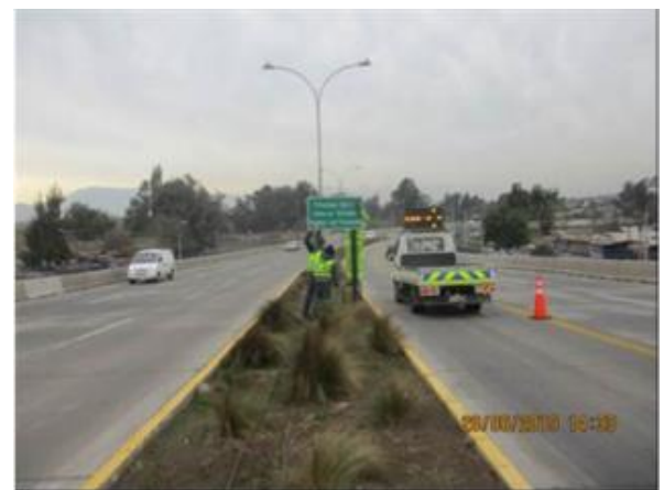
Mantención de señales verticales
