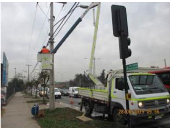
Mantención de luminarias
