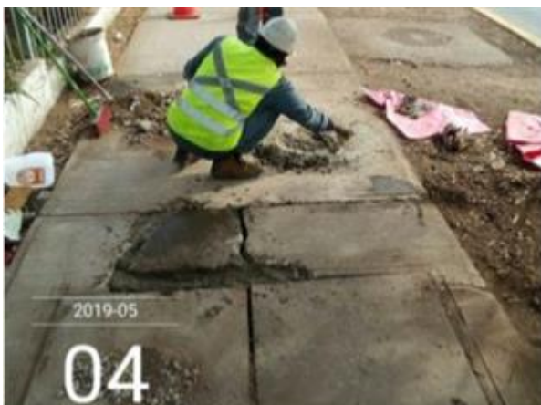
Reparación de aceras peatonales
