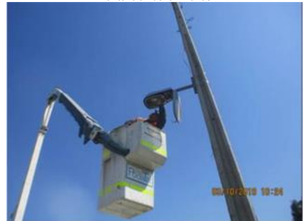
Mantenición de luminarias
