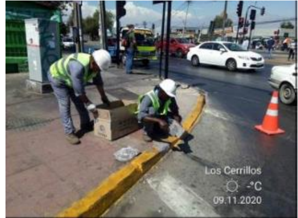
Reparación de soleras
