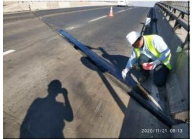
Sello de fisuras en viaducto
