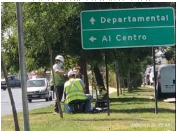
Mantenición de sistema de conteo de vehículos
