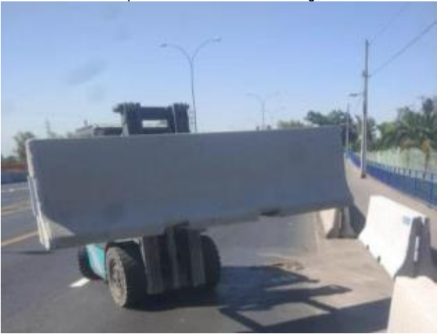
Reposición de barreras de hormigón
