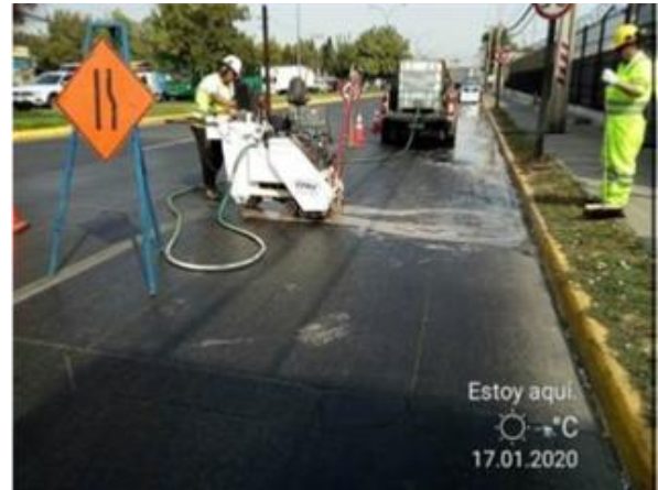
Reparación de pavimentos
