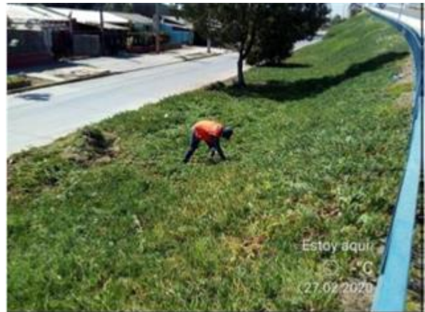
Desmalezado de talud
