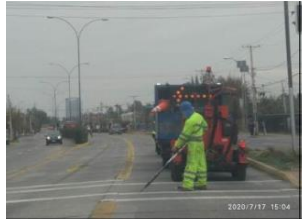
Reparación de sello de juntas
