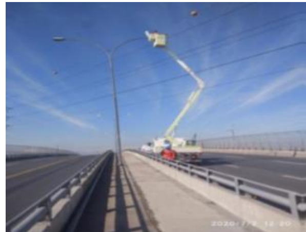
Mantenición de luminarias
