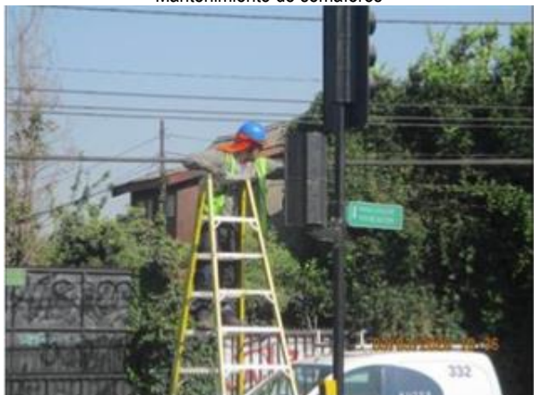
Mantenimiento de semáforos
