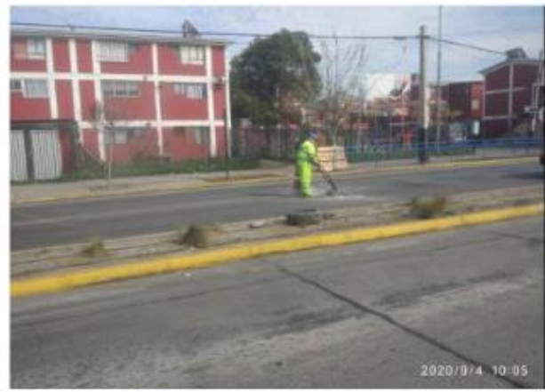
Reparación de baches pavimentos de hormigón Av. Las Rejas – Aysén
