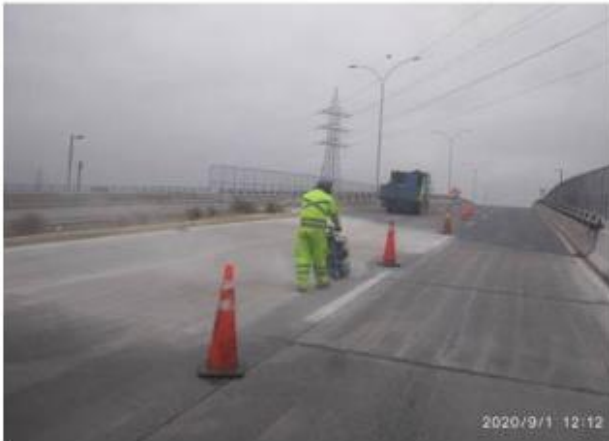
Nivelación de tapas de cámaras
