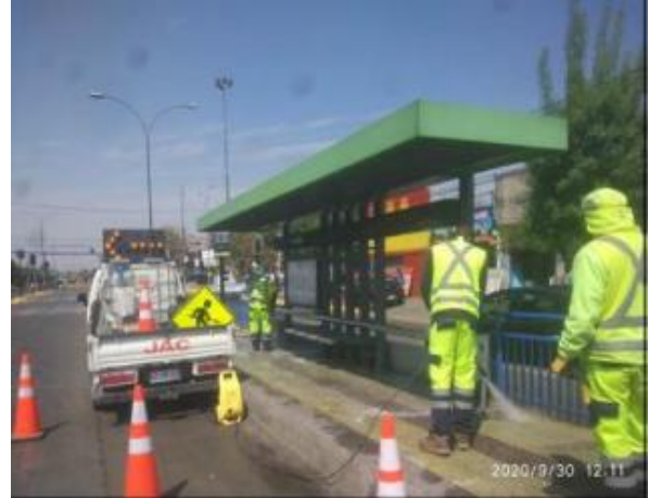
Mantención de refugios peatonales
