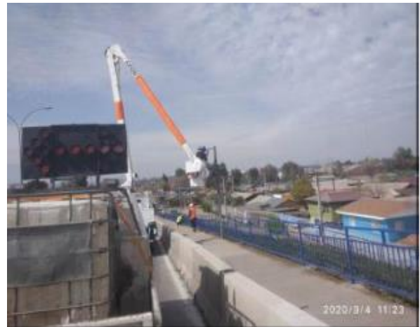
Mantención de luminarias
