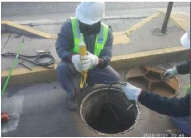
Nivelación de tapas de cámaras
