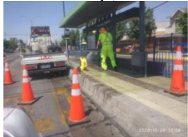
Mantenición de refugios peatonales
