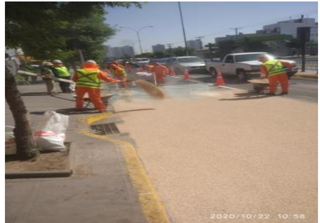
Instalación sello alta fricción
