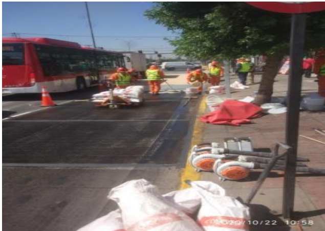
Instalación sello alta fricción
